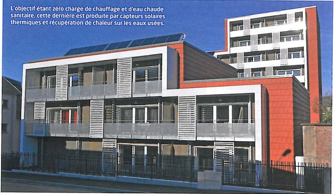
particulière a été apportée à la suppression des ponts thermiques: fixation à rupture de pont pour la paille, menuiseries triple vitrage isolées. Les 26 logements T3 et T4 d'une surface moyenne de 80 m<sup>2</sup>, tous traversants, sont accessibles depuis une coursive protégée en façade nord et ouverts largement vers le sud. Des balcons filants sur les façades sud permettent de se protéger du soleil
